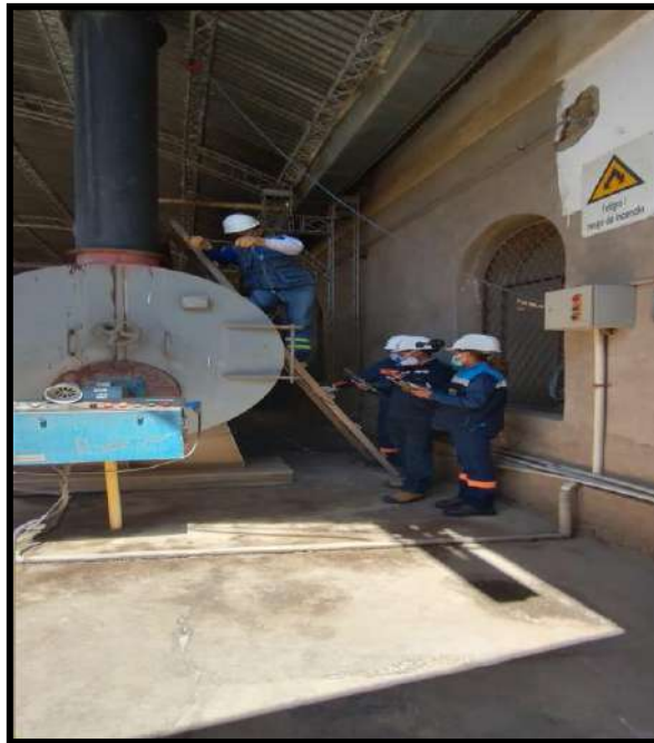
Fotografía 16. Medición de emisión de gases a caldero industrial empresa PRETENSA
